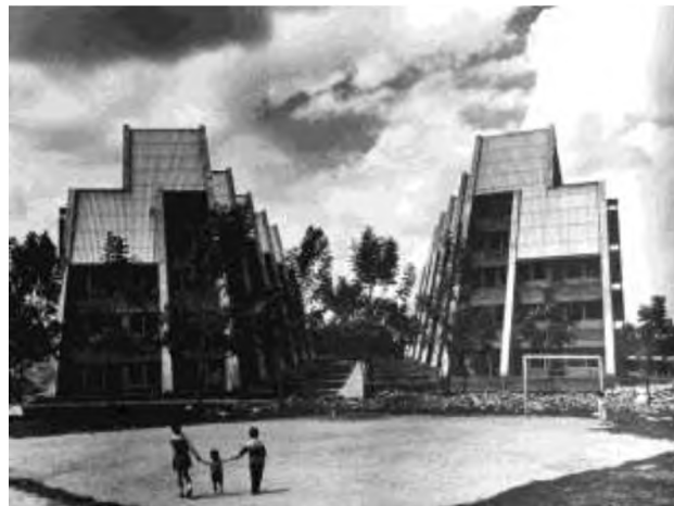
Fotografía No 9. Edificios de la Fundación Cristiana de la Vivienda, año 1963
