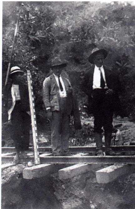
Ilustración 11 Trabajos de nivelación adelante del sector del Boquerón
