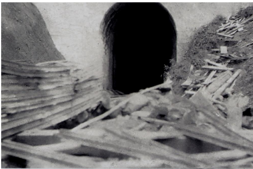
Ilustración 7 Túnel del Boquerón durante su construcción en 1923
