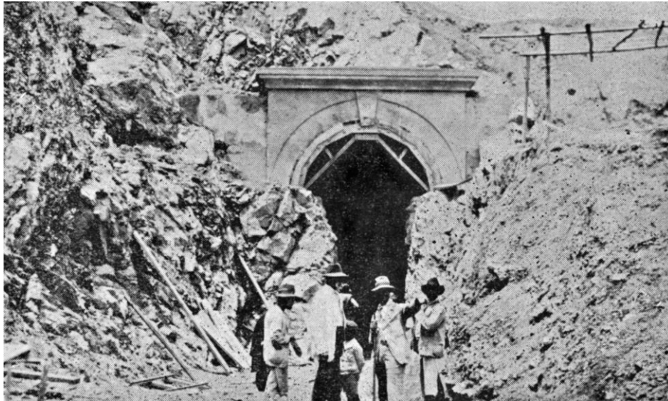
Ilustración 21 Túnel de La Cascada - Conformación de la sección inferior
