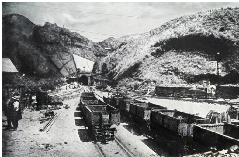
Ilustración 1 Túnel de La Quebra – Trabajos de Construcción
