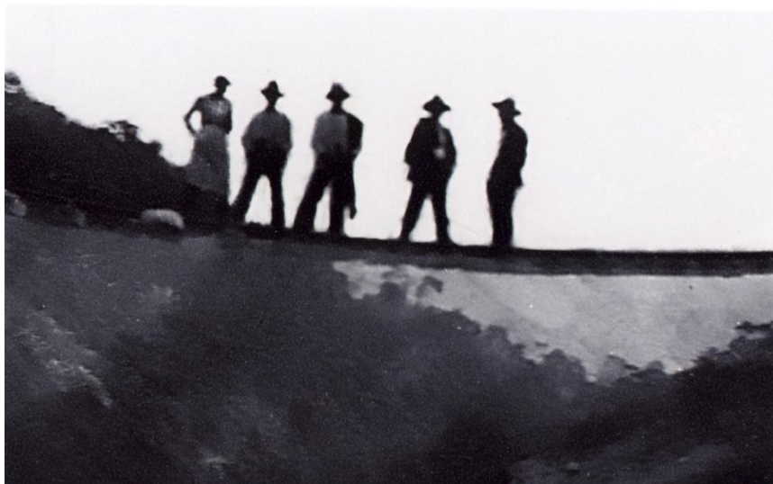
Ilustración 8 Viaducto de 50 metros sobre el río San Eugenio
