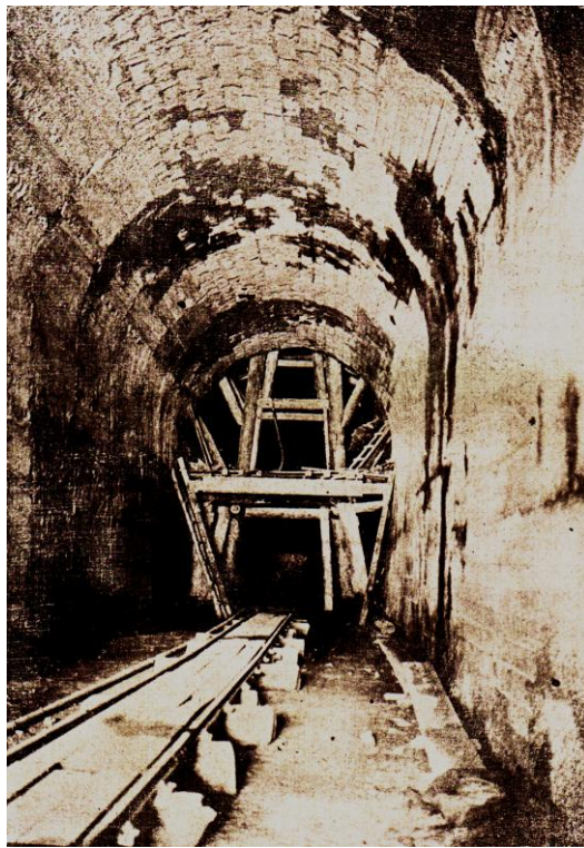
Ilustración 19 Método de Excavación empleado en el Gran Túnel de Calarcá
