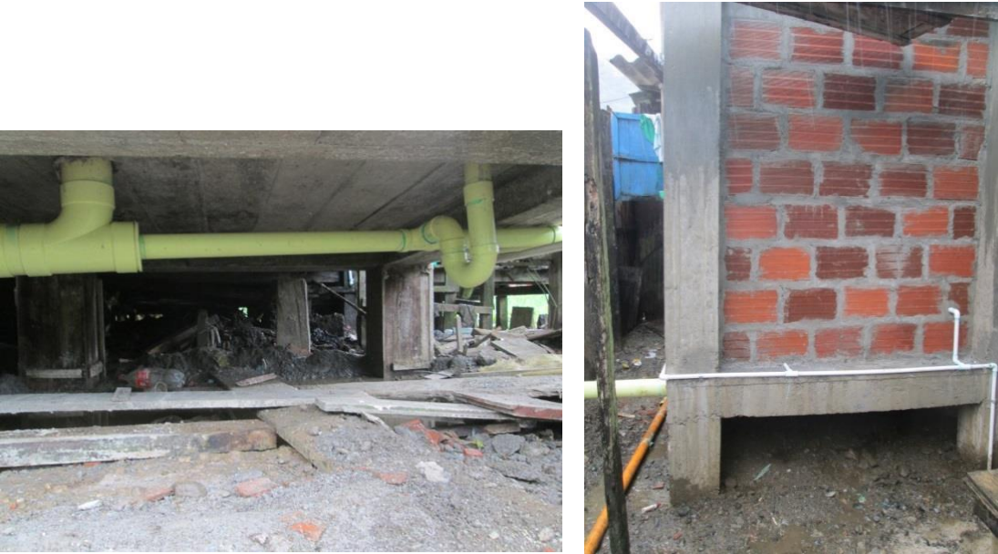
Figuras 6.4 y 6.5. Vista externa de unidad sanitaria construida con el subsidio de conexiones intradomiciliarias. Fuente: Minvivienda, 2016.
