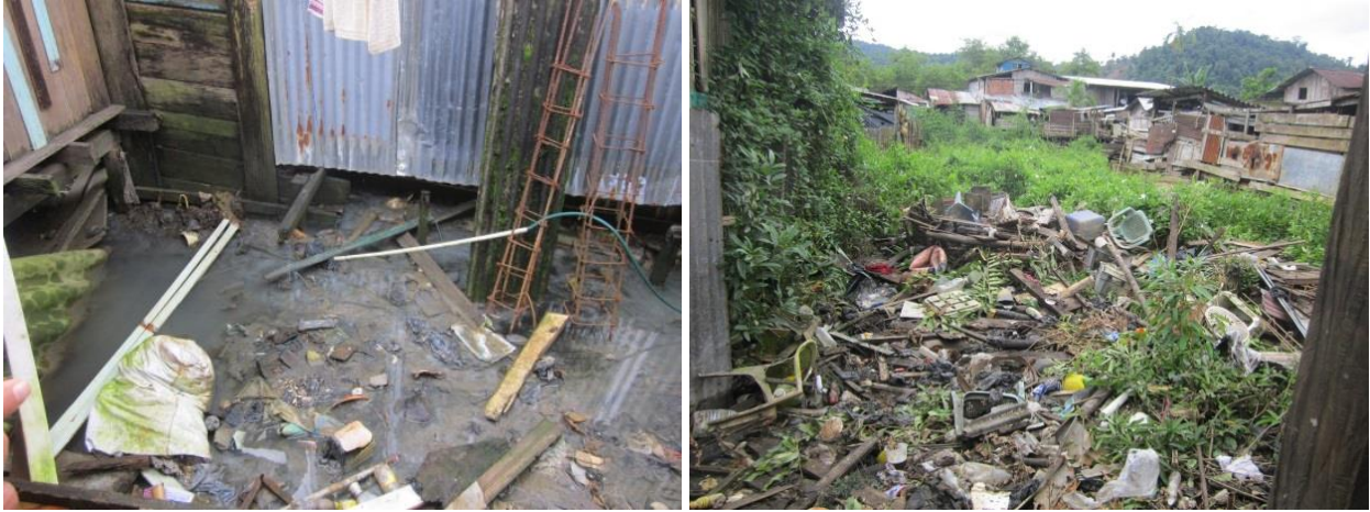
Figuras 3.3 y 3.4. Características de los suelos al interior de los predios para la construcción de unidades sanitarias, Ciudad Mutis (Bahía Solano). Fuente: Minvivienda, 2016.
