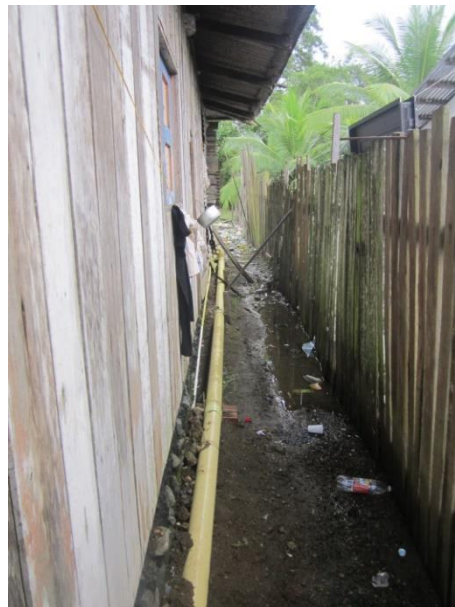
Figuras 5.5 y 5.6. Instalación de redes internas de acueducto y alcantarillado, Ciudad Mutis (Bahía Solano). Fuente: Minvivienda, 2016.
