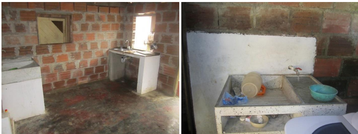
Figuras 5.1 y 5.2. Viviendas intervenidas con la instalación de lavadero y lavaplatos, Ciudad Mutis (Bahía Solano). Fuente: Minvivienda, 2016.
