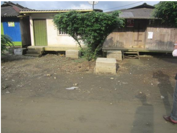
Figura 1.3. Acometidas de acueducto y alcantarillado, Ciudad Mutis (Bahía Solano). Fuente: Minvivienda, 2015.
