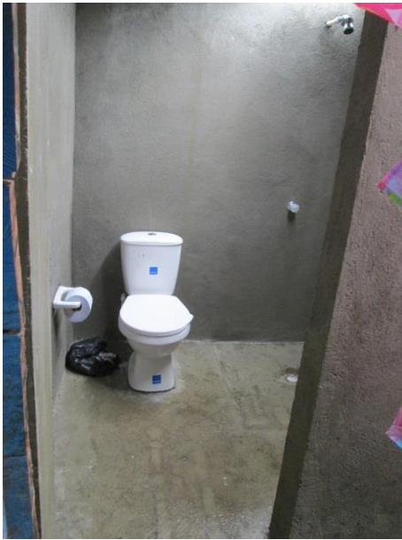
Figuras 6.6 y 6.7. Vista interna del baño construido. La intervención cubrió el valor máximo del subsidio por lo cual no se pudo adecuar internamente con pintura, enchape y puerta. Barrio Chocolatal, Ciudad Mutis. Fuente: Minvivienda, 2016.
