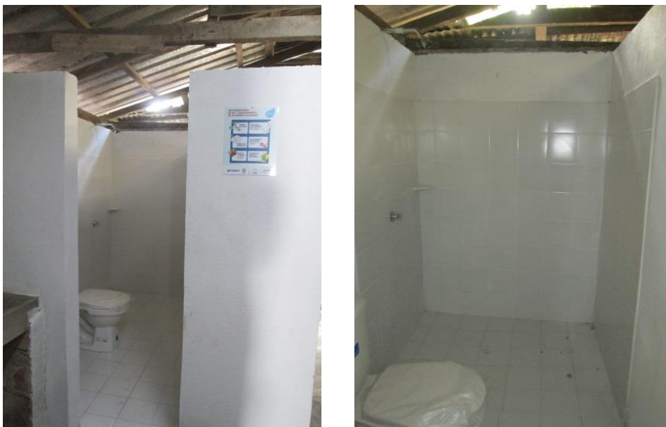
Figuras 5.7 y 5.8. Instalación de acrílico educativo en las viviendas beneficiadas y adecuación de espacios existentes de baño, Ciudad Mutis (Bahía Solano). Vías y viviendas de Ciudad Mutis. Fuente: Minvivienda, 2016.
