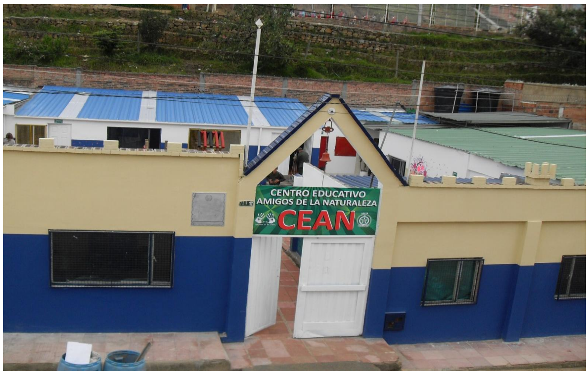
Figura 8: Remodelación Sede Caracolí.
