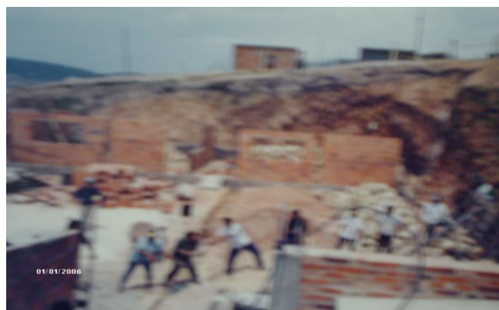
Figura 5: Construcción Sede Caracolí.
