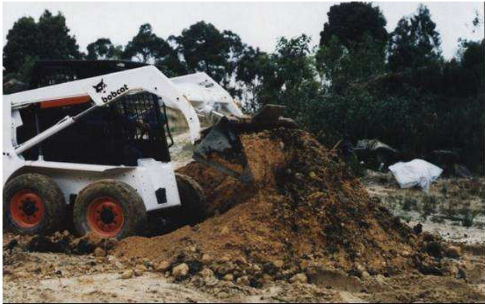
Figura 9. Homogenización de las mezclas de biosólidos y estériles utilizando la pala mecánica del bobcat.
